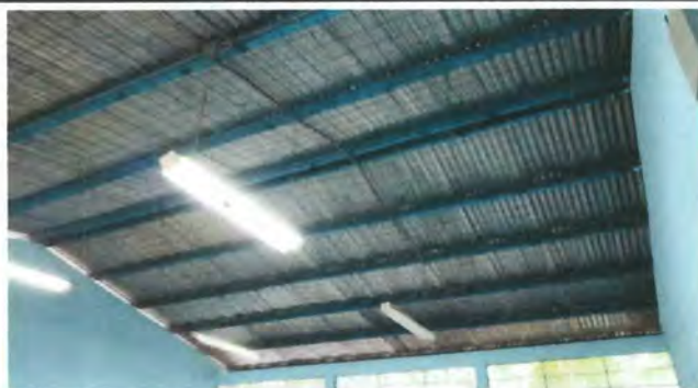
Foto 5: Reparación de costaneras debido al óxido y deterioro, Aula 1 y 2 de alumnos del módulo 2.
