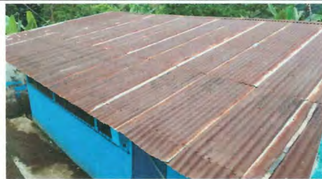
Foto 6: Cambio de entechado del módulo 2 por que la lámina esta muy deteriorada.
