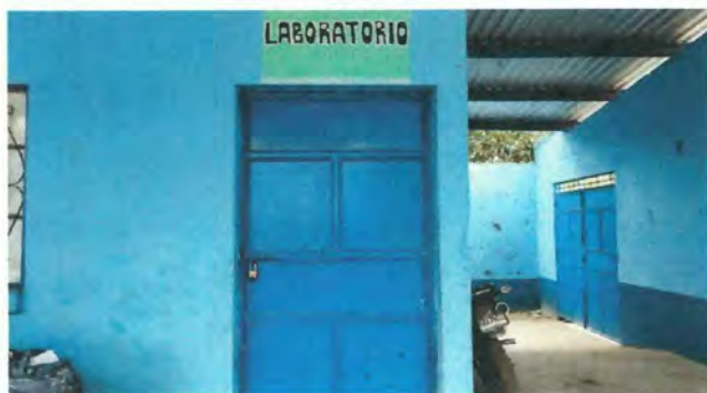
Foto 3: Cambio de chapa de puerta de laboratorio de computación del Módulo 5.
